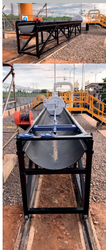
LANZADOR Y BANDEJA RECOLECTORA DE RASPADORES
