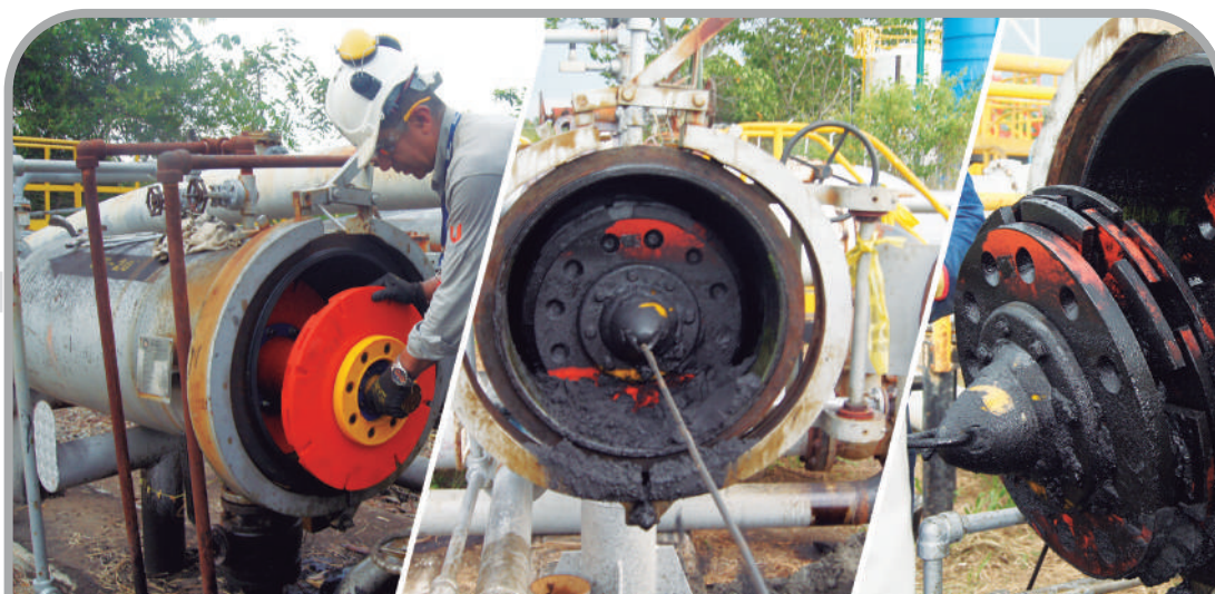
Limpieza con altos niveles de arena
